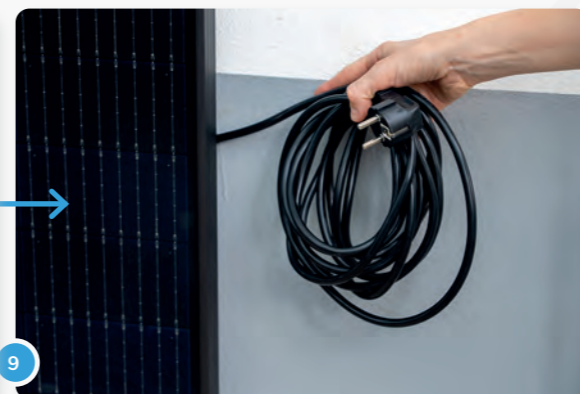
9 Achte darauf, dass du das Stromkabel vor dem Fixieren der Panele hinten herausführst, sodass es später griffbereit zum Einstecken liegt.
