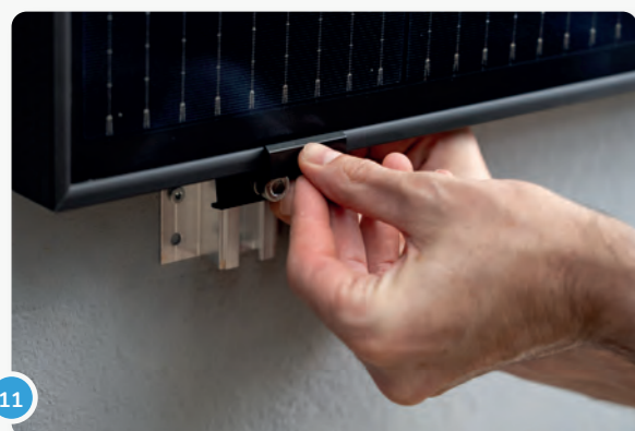
11 Die Klemmen werden von oben bzw. vorne in die Schienen gedrückt. Beim Hinunterdrücken dreht sich die Feder um 90° und schnappt ein.
