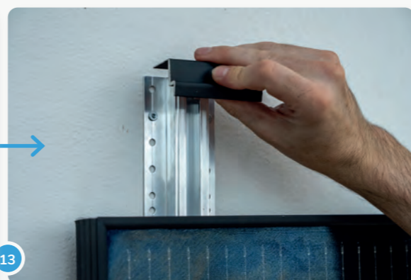
13 Diese Schritte werden jetzt für die anderen drei Schienen (pro Panel) wiederholt.
