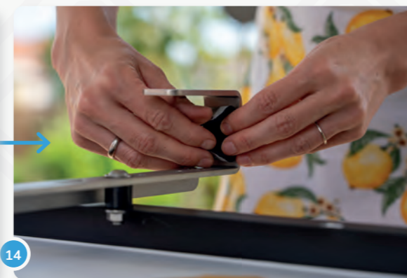
14 Wenn du einen eckigen Handlauf hast, kannst du jetzt die Gummistreifen als Kratzschutz einkleben.
